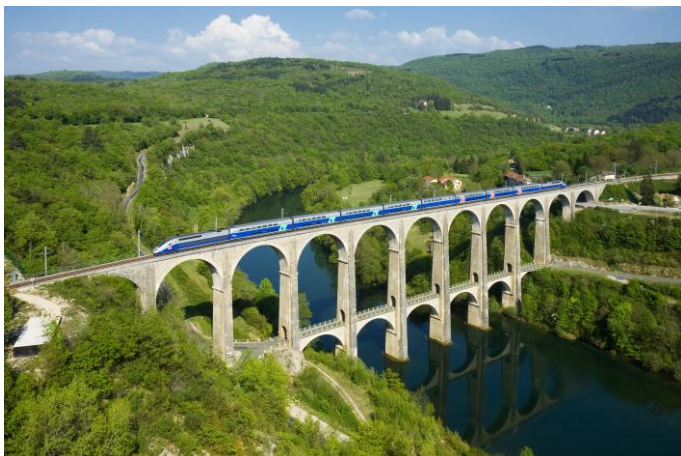
Viadukt von Cize-Bolozon mit einem Duplex-TGV
